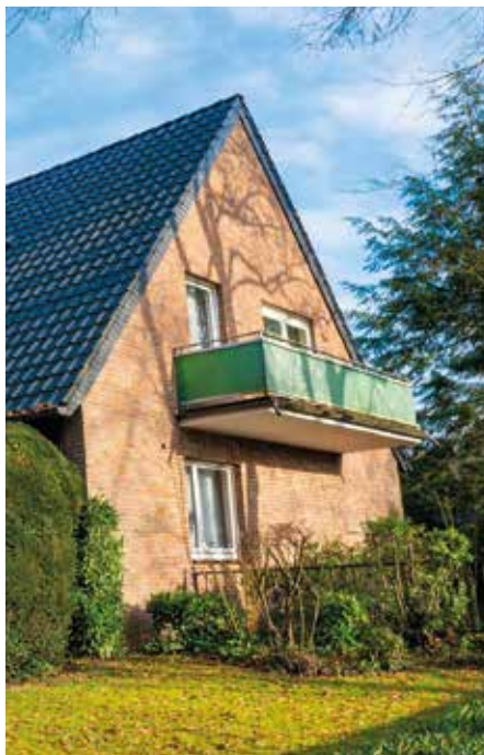
Erbbaupacht hat viele Träume vom Eigenheim erfüllt – nun droht manchem ein böses Erwachen.
